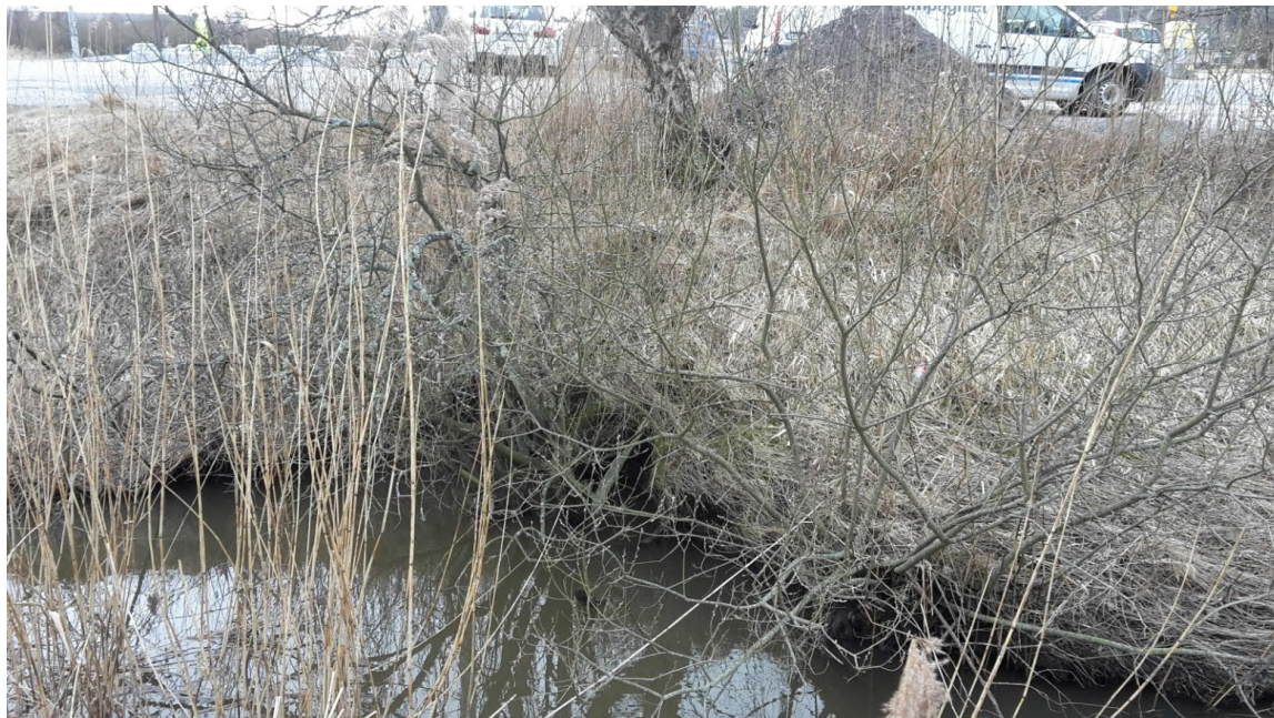
Figur 4 – Erosion vid skarp ytterkurva.
